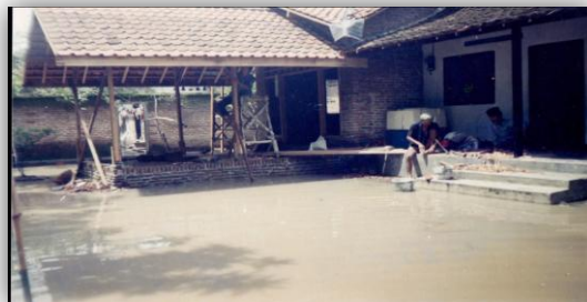
Gambar 3.1: Pembangunan Gedung Pertama
