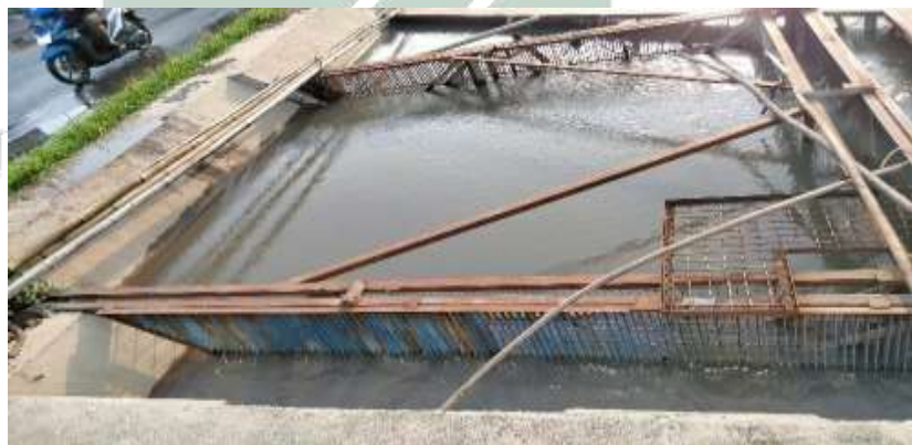
Gambar 4.6 Unit Intake dengan Barscreen 5 cm
