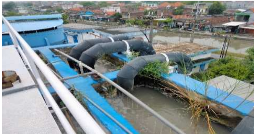
Gambar 4.9 Bak Koagulasi Flokulasi
