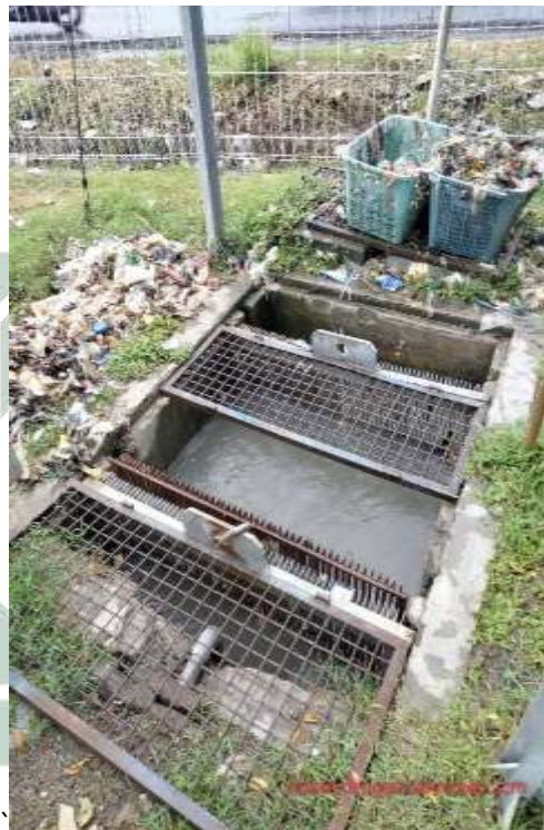
Gambar 4.7 Unit Intake dengan Barscreen 2 cm
