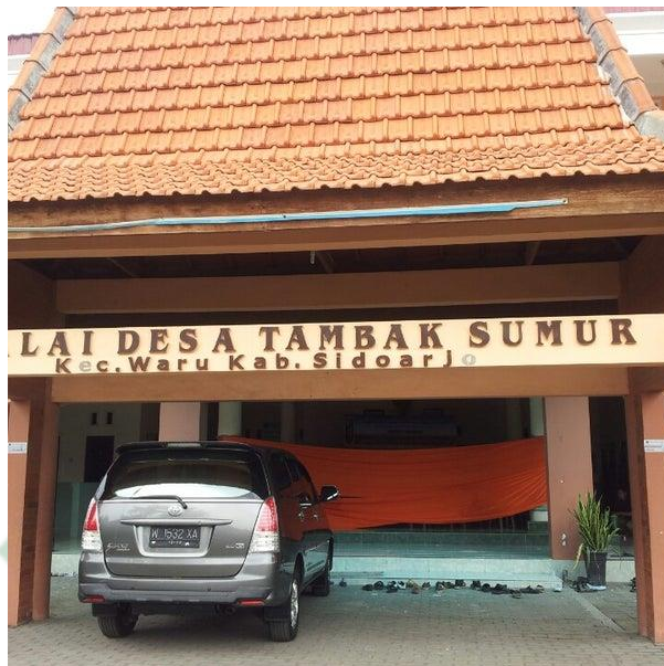
Gambar 5.10 Balai Desa Tambak Sumur
