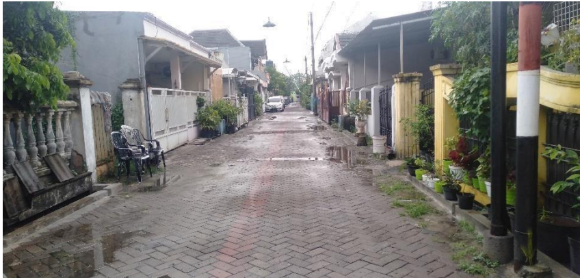
Keadaan salah satu blok di Perumahan Deltasari Indah
