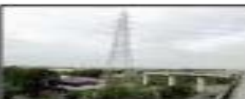
Rangka menara listrik tegangan tinggi (SMRT)
