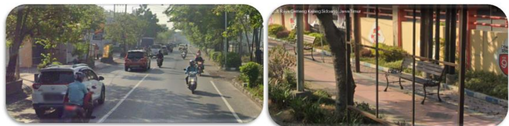
Gambar 2.2 Kondisi Jalan dan trotoar
