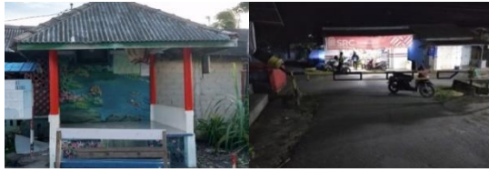
Gambar 5. 5: Infrastruktur Keamanan Poskamling dan Portal Jalan
