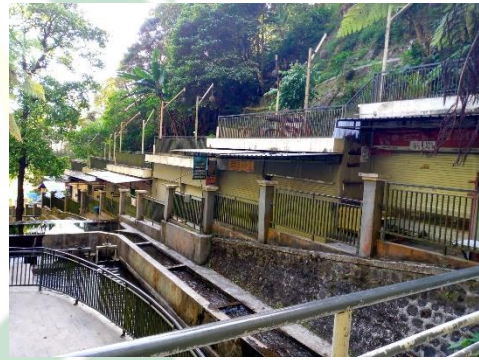
gambar 4.7 kompleks ruko sebelah Utara bagian timur kawasan air terjun sedudo (Sumber : Dokumentasi peneliti)
