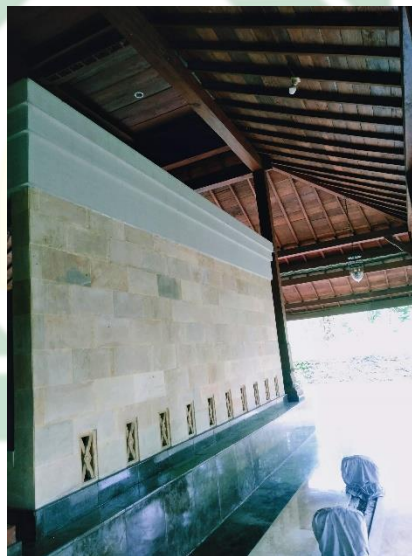
Gambar 3.3.6 Dinding pada Cungkup Makam
