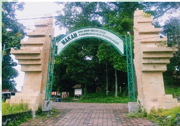
Gambar 3.3.1 Gapura Bentar Komplek Makam
