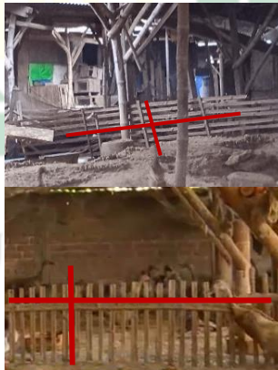
Gambar 4.3. Gambar Pagar Pembatas Terbuat dari Bambu yang Saling Tegak Lurus.
